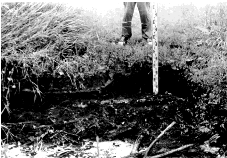
Рис. 54. Разрез земляного полотна Московско-Сибирского (Казенного) тракта к северо-западу от д. Форпост Большеуковского района Омской области. Фотография 2002 г. Вид с Ю
