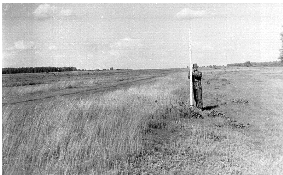
Рис. 42. Земляное полотно Купеческого (Коммерческого) тракта XIX – начала XX в. к северо-востоку от д. Заготзерно Саргатского района Омской области. Фотография 2000 г. Вид с Ю
