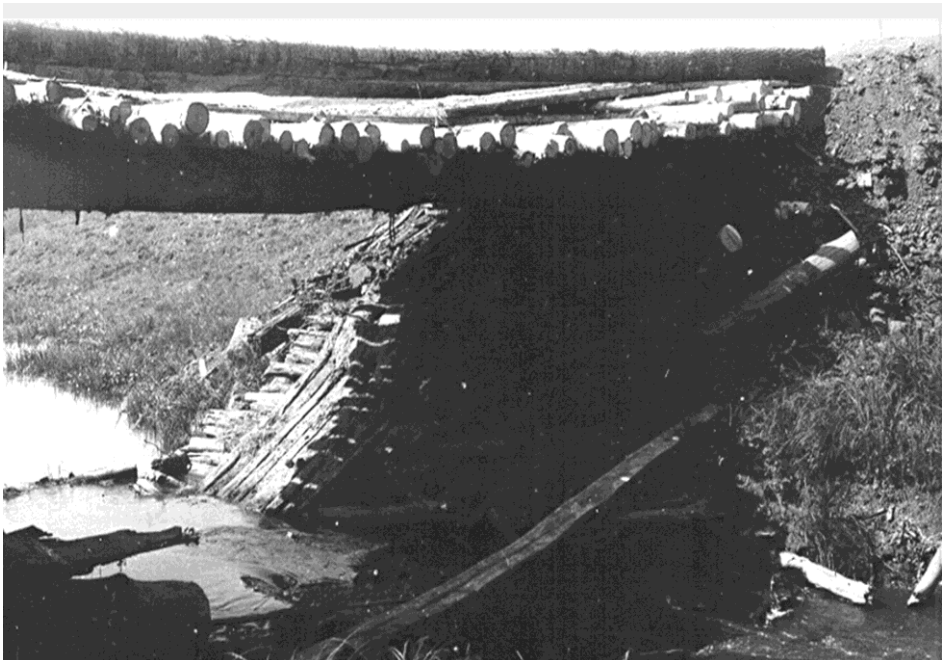
Рис. 16. Балочный мост у д. Атачку Тарского района Омской области через р. Атачку. Фотография 1999 г. Вид с Ю
