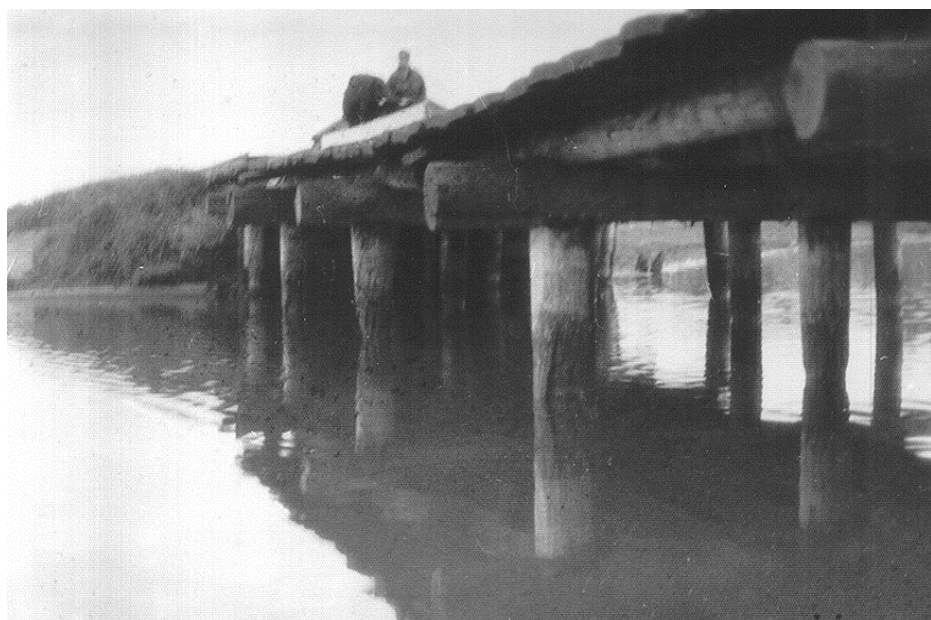
Рис. 23. Свайный Общественный мост через р. Ошу в д. Усть-Логатке Крутинского района Омской области. Фотография 2000 г. Вид с Ю
